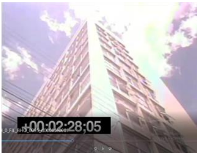
Fotograma 12 – Prédio em Teresina/PI
