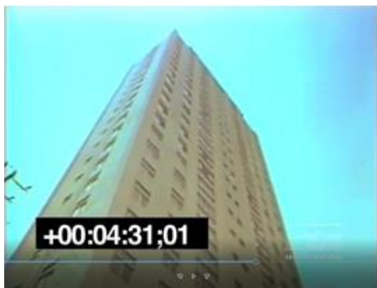
Fotograma 10 – Prédio indicado como de construção recente à época. Manaus/AM
