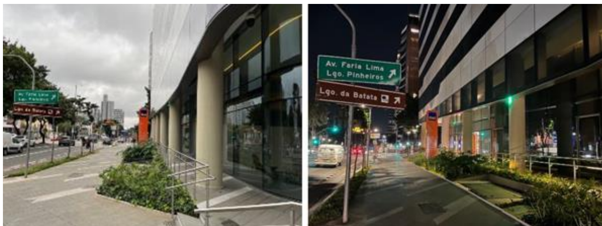
Figura 5 – Fachada e marquise do edifício A: diurna e noturna
