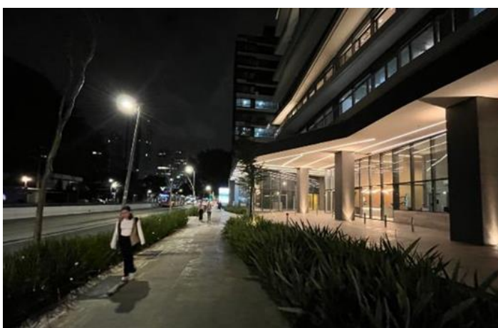
Figura 3 – Iluminação e marquise para a proteção do pedestre – Edifício B
